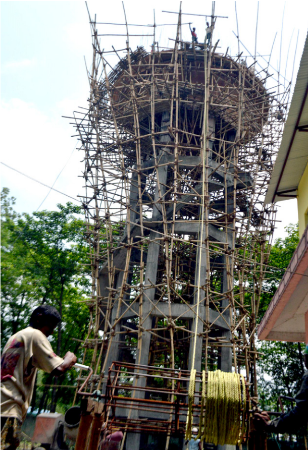
मोरङको जहदा गाउँपालिकामा बन्दै गरेको खानेपानी टंकी ढलानका क्रममा लगाइएको उपाय। वाल्टीमा भरेको सिमेन्टको घोल टंकीमाथि पुर्‍याउन फलामबाट बनेको चक्का घुमाएर डोरी बेदै मजदुर। तस्वीर : उद्घोष
